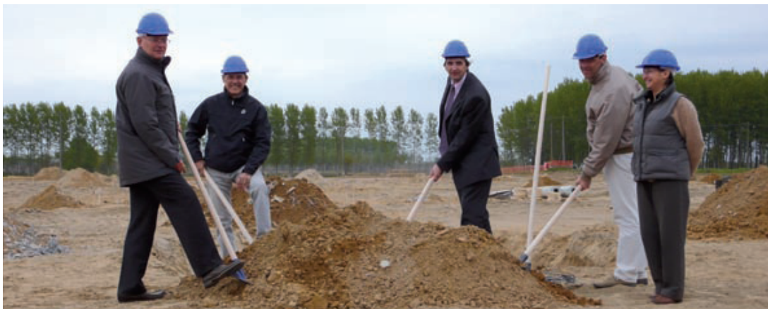
CANTIERE APERTO. NELL'AREA DOVE SORGERÀ IL CENTRO LOGISTICO FERCAM, SI COMINCIA A LAVORARE. NELLA FOTO DA SX: THOMAS BAUMGARTNER, AD FERCAM, MASSIMO GUIZZARDI, AD TERRY STORAGE, MARCELLO CORAZZOLA, DIRETTORE DIVISIONE LOGISTICA FERCAM, GEOM. COLOMBO GIULIANO E PAOLA SACCHI, SINDACO DI OTTOBIANO.
